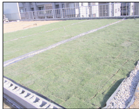
圖 7 科學與航太館頂樓施工後
