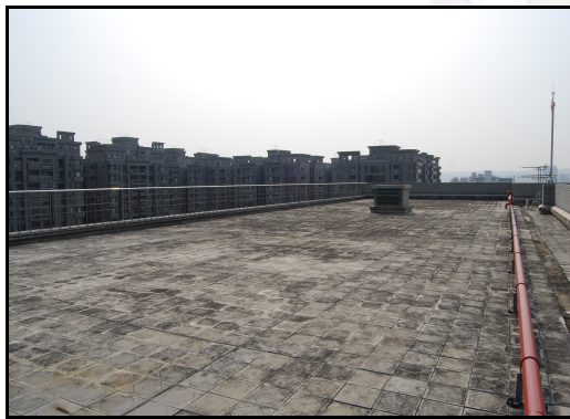
圖 6 科學與航太館頂樓施工前
