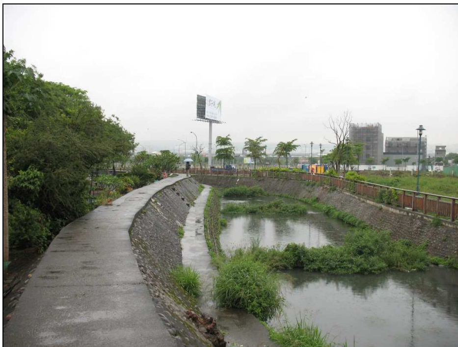
圖 8 沿途所見之水域環境，亦可見兩岸堤防之設置與可供人步行之情況
