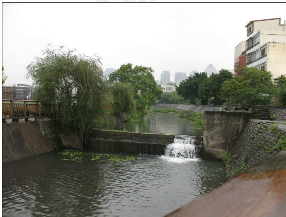
圖 9 游堰壩處之流水情況，圖中是從下游往上游方向拍攝，可見溢流之水僅於黎明溝左岸部分。另左岸為一引水道之設置，從圖中可見其開門之機制
