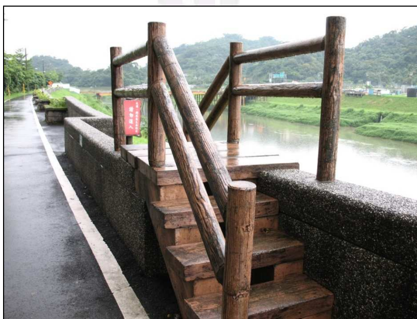
圖 19 此為自行車道上跨越矮牆之步道設計；圖左即為自行車道部分，而車道的另一側是為堤防保護之地面
