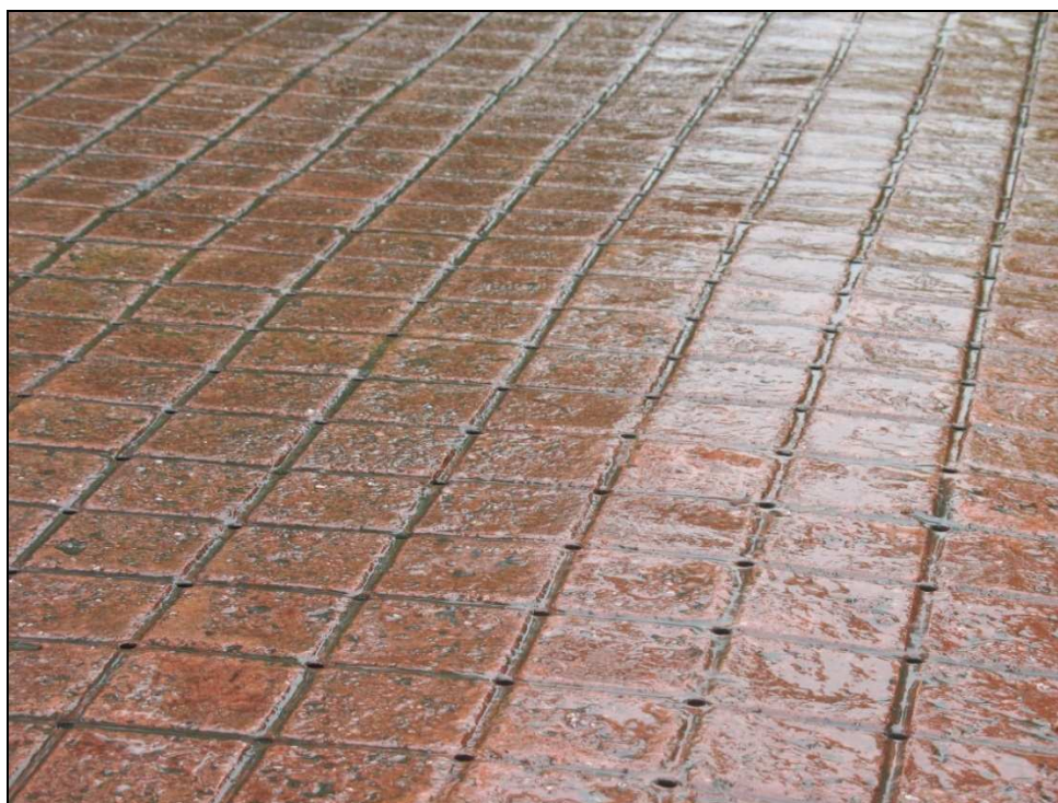
圖 26 現場下雨時的路面情形，從圖中可發現當柏油路表面出現漫地流時，多孔隙的路面依然僅有濕漉感
