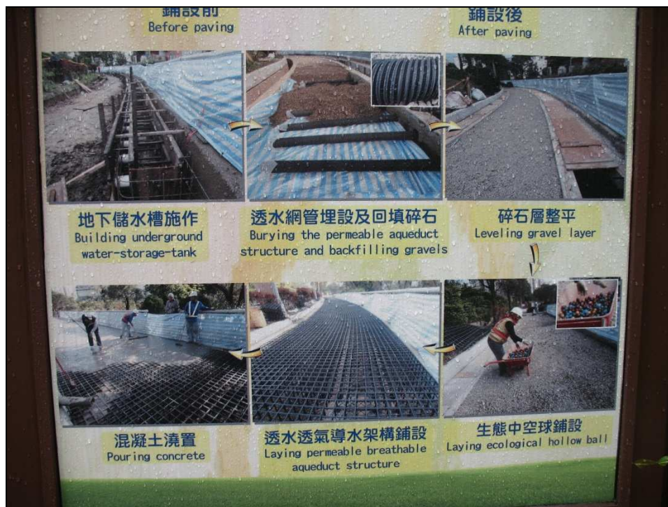
圖 24 此圖為生態工法施工流程圖，可以清楚看見生態工法施工的過程
