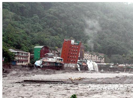
圖 20 護岸破壞：傾倒破壞
