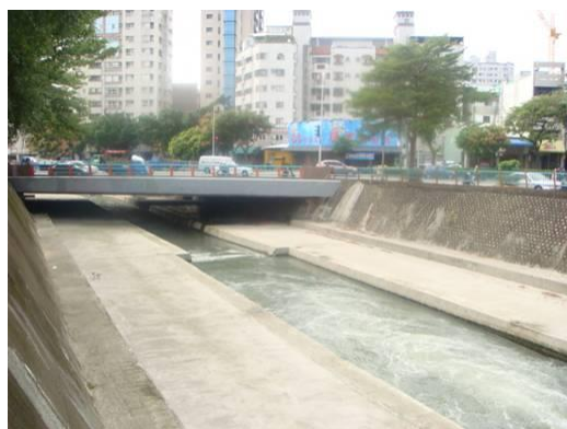
圖 1 混凝土護岸工法
