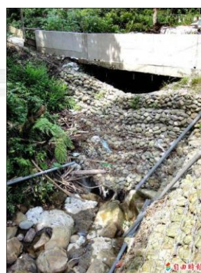
圖 22 護岸破壞：洪水沖毀
