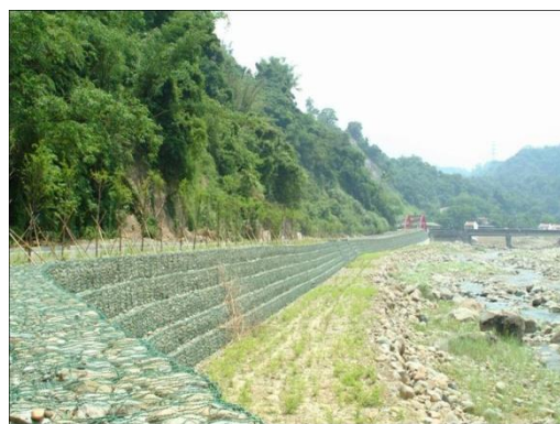
圖 2 蛇籠護岸工法
