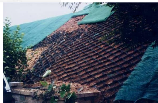
圖 16 蜂巢圍束網格堆疊護岸
