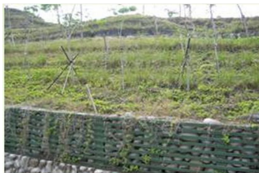
圖 17 混凝土格框護岸
