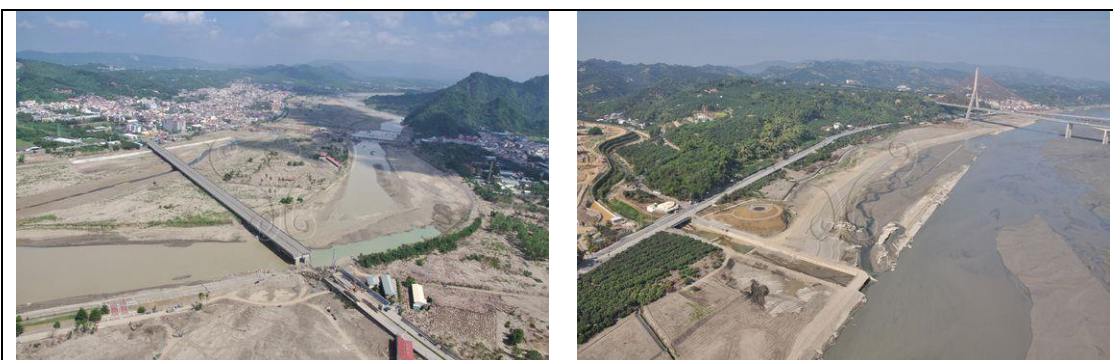
圖 24 台灣河川土砂大量淤積照片
