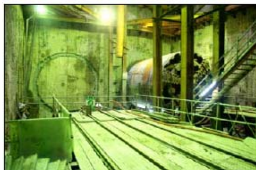
潛盾機 右邊已鑽出 左邊還未鑽出
