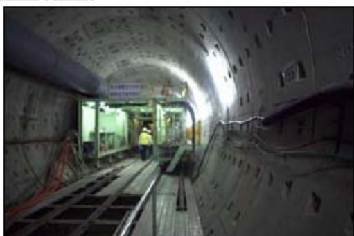
施工中隧道一環片已組裝完成
