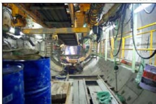
操作室後端的泥土輸送帶
