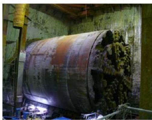
【2號潛盾機貫通隧道出機景觀】
