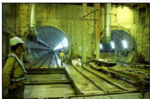
準備進入施工中的隧道
