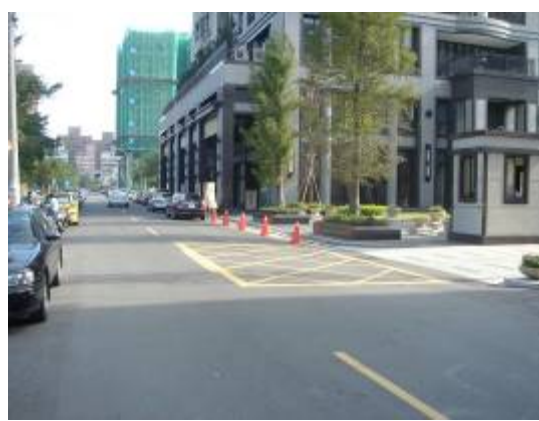
圖 元亨利貞道路
