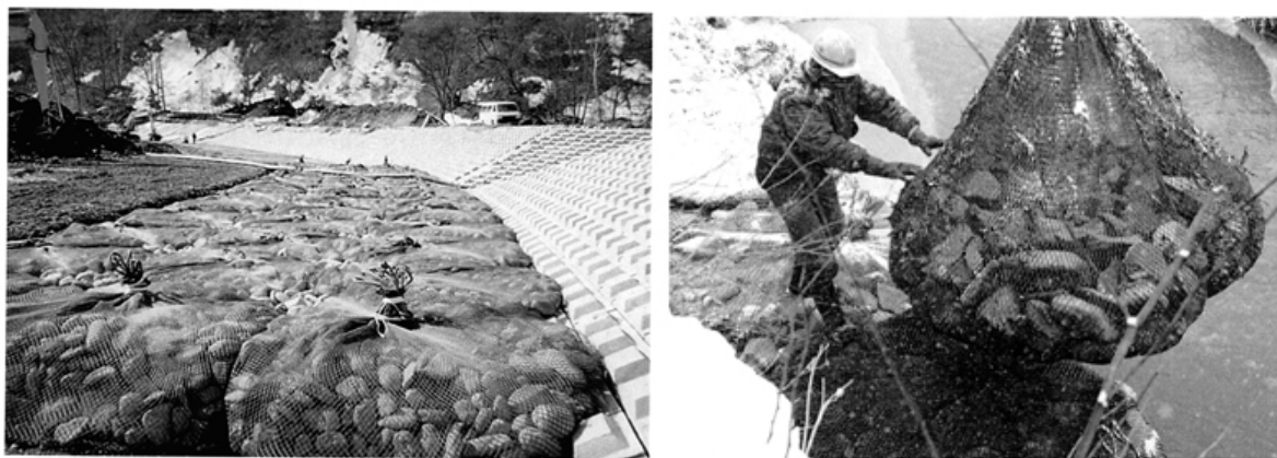
照片 2-1 袋型護坦工
