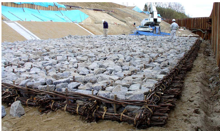
照片 2-2 柴枕護坦工
